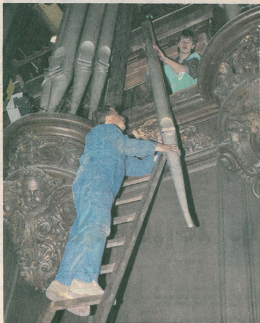
Le démontage des tuyaux a été effectué en mal
